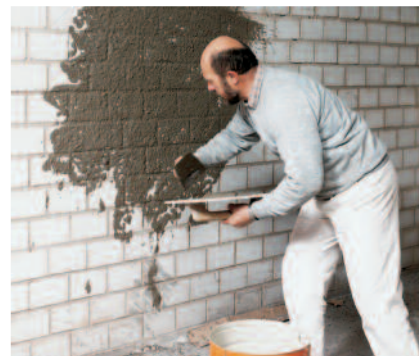
Ein mit PCI Emulsion hergestellter Spritzbewurf verbessert die Haftung von Putz.
